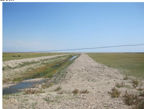
Рис. 4. Дрена на западном побережье Иссык-Куля для снижения уровня грунтовых вод.
