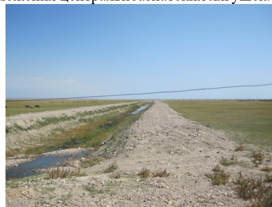
Рис. 4. Дрена на западном побережье Иссык-Куля для снижения уровня грунтовых вод.
